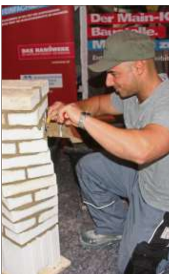
Wie richtig gemauert wird, zeigte Giovanni Mauro auf der Lehrbaustelle.
