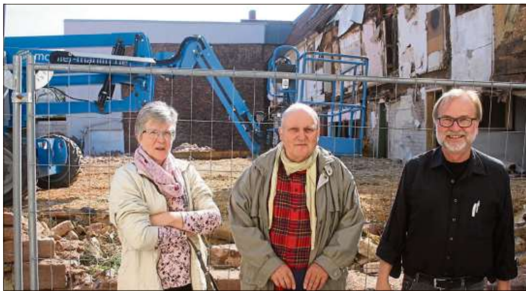
Architekt Rolf Krüger (rechts) führte Interessenten über die Baustelle in der Schlüchterner Krämerstraße.
