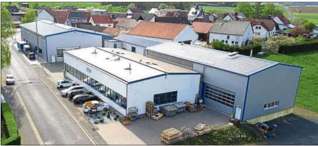
Die Firma ITW – Industrie-Technik Werth – hat ihren Produktionsstandort um einen rund 800 Quadratmeter großen Produktionsbereich sowie 270 Quadratmeter Büro- und Geschäftsräume erweitert.
