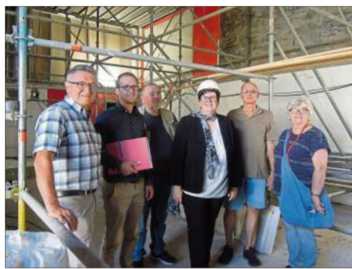
Bei einem Besichtigungstermin im Generationentreff erläuterte Ingenieur Matthias Engelkamp den Fortgang der Bauarbeiten (von links: Godehard Goralewski, Matthias Engelkamp, Fred Halliday, Helga Weber, Clemens Michel und Monika Groß).
