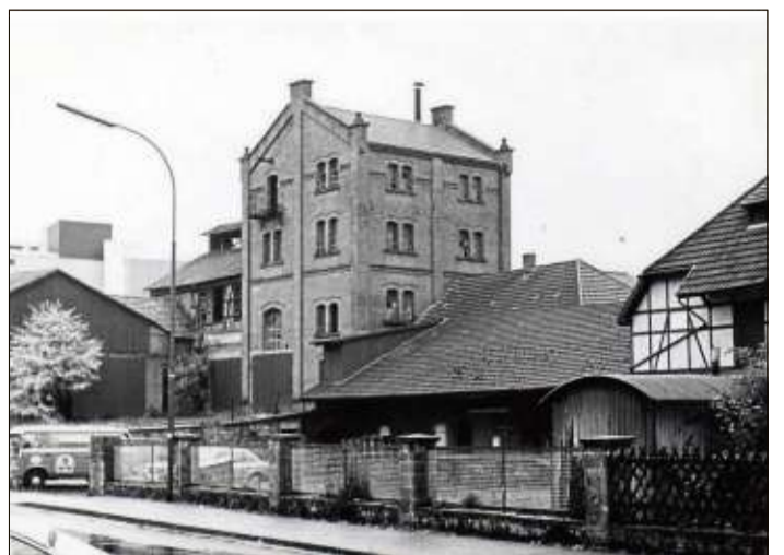
Viele alte Gebäude wie die Brauerei Thaler wurden abgerissen.
