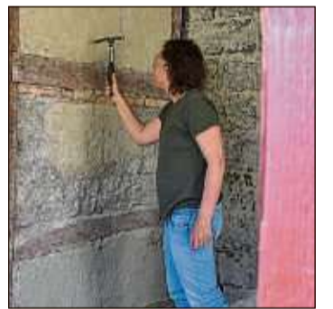
Das Sanieren des Anbaus als gemeinsames Projekt: Stephanie Philipp bei der Arbeit.
