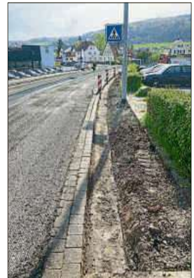
In der Alten Bahnhofstraße wurde die Straßendecke saniert.
