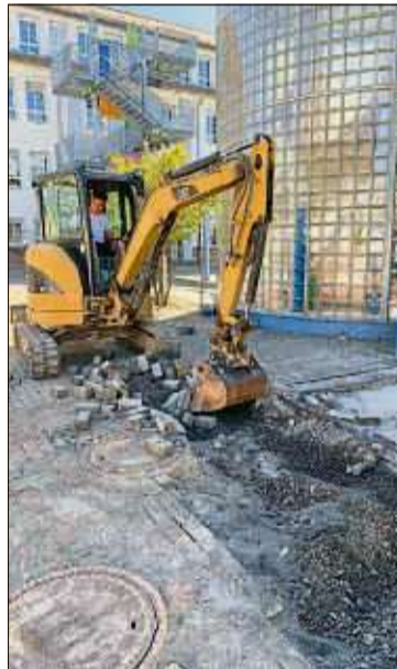
An der Stadtschule, einer verbundenen Haupt- und Realschule, laufen Tiefbauarbeiten.
