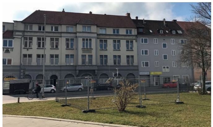
▲ Stadtklima-Messstation in Hannover, Weidendamm.
