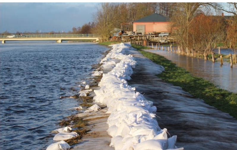
◀ Deichsicherung an der Treene. (Quelle: Eider-Treene-Verband)
