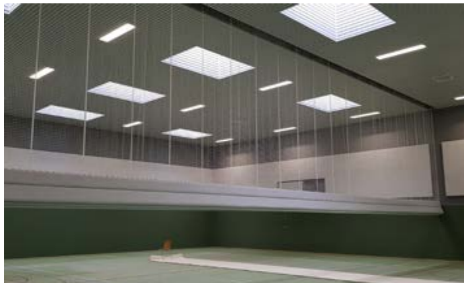
Zwei halboffenen Trennvorhänge der sanierten Kirschberghalle ermöglichen, dass hier bis zu drei Gruppen gleichzeitig trainieren können.
