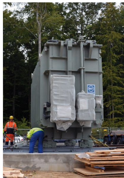
Über Schienen werden die Trafos an ihre Position gebracht. Gezogen werden die Trafos nur mit Seilzügen und Muskelkraft.
