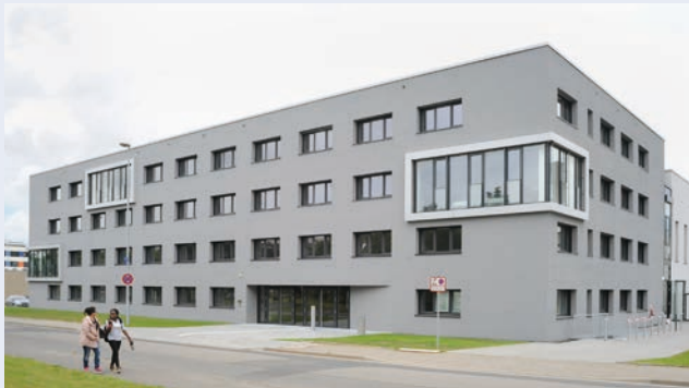
Neuer Forschungsbau für das Helmholtz-Institut Mainz.
