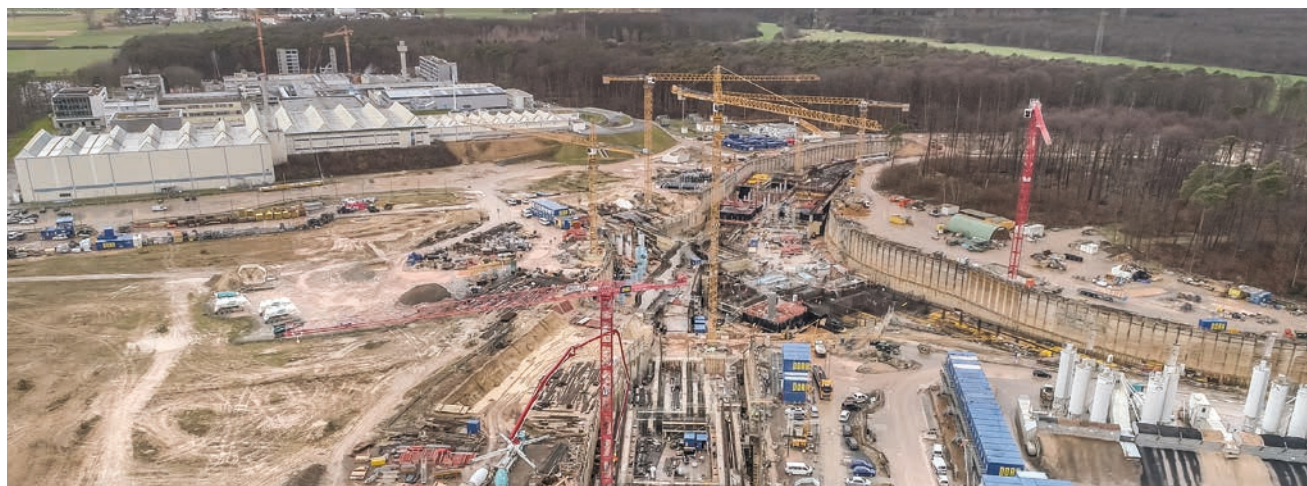
Die Entwicklung schreitet voran: Rechts im Foto ist der nördlicher Teil des Baufelds mit dem Tunnel für den großen Ringbeschleuniger SIS100 zu sehen, im Hintergrund links die bestehenden GSI-Gebäude, davor ein Teil des südlichen Baufelds, das nun immer stärker entwickelt wird.
