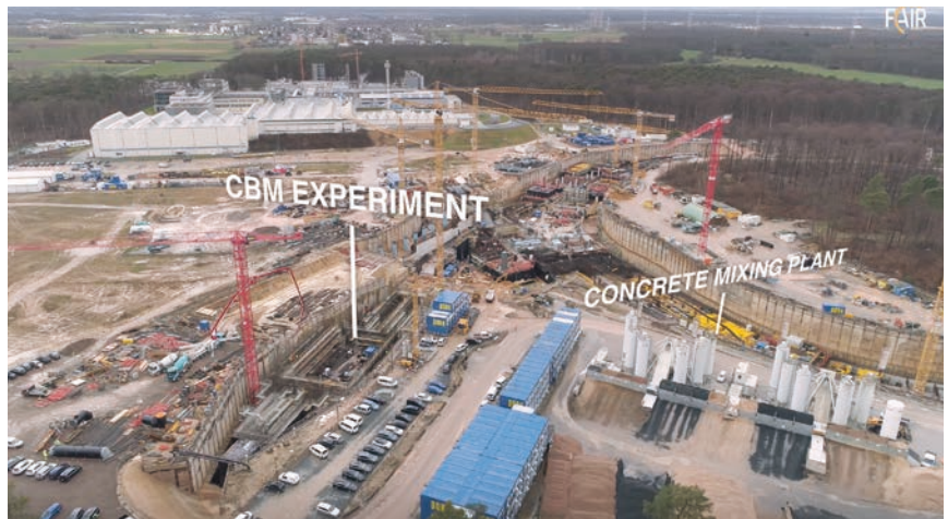
Das Mega-Bauprojekt FAIR lässt sich per Drohnenflug besichtigen.
