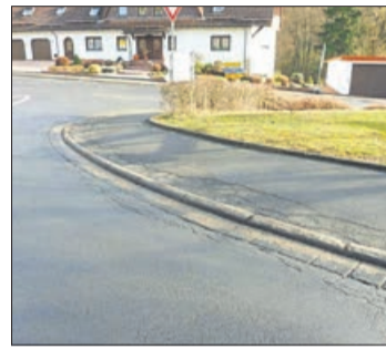
Die Straßenbauarbeiten in Uerzell haben begonnen. Foto: Stadtverwaltung
