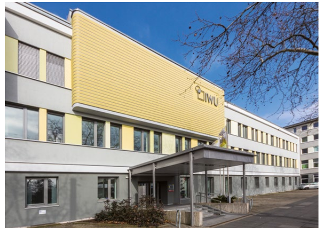
IWU-Gebäudefassade nach der Modernisierung
