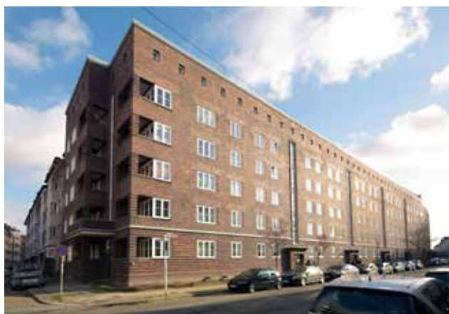
Wohnblock mit BHKW der STÄWOG Bremerhaven (© STÄWOG)
