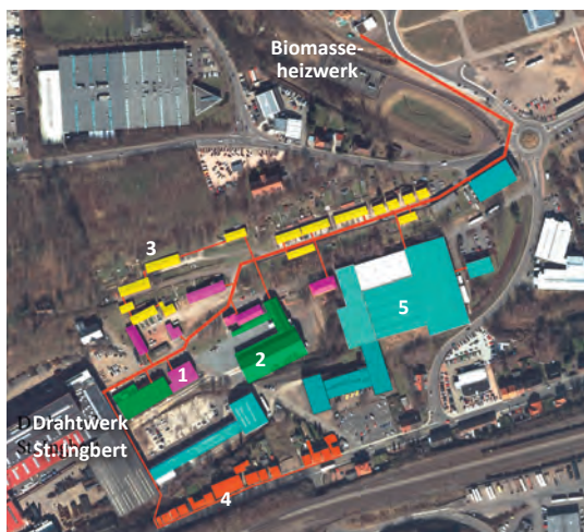
Abbildung 1: Quartier „Alte Schmelz“ mit Nahwärmenetz für die Wärmeversorgung mittels der Prozessabwärme aus dem Drahtwerk St. Ingbert (DWI) und als Spitzenlast-/Reservesystem das Biomasseheizwerk im Drahtwerk-Nord-Areal (DNA) St. Ingbert.
