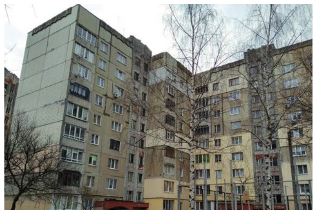
Hoher Sanierungsbedarf – Gebäude in Lviv
