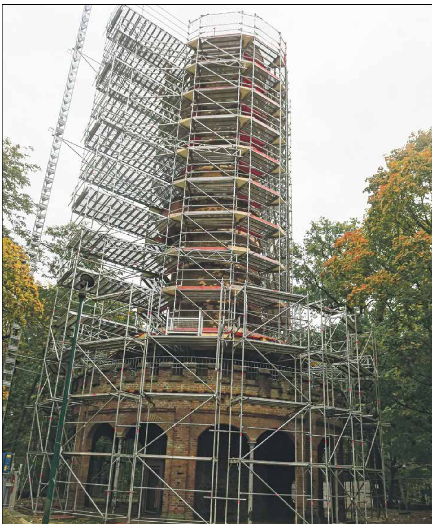
IMPOSANT. Der eingerüstete Ludwigsturm. (Zum Bericht)
