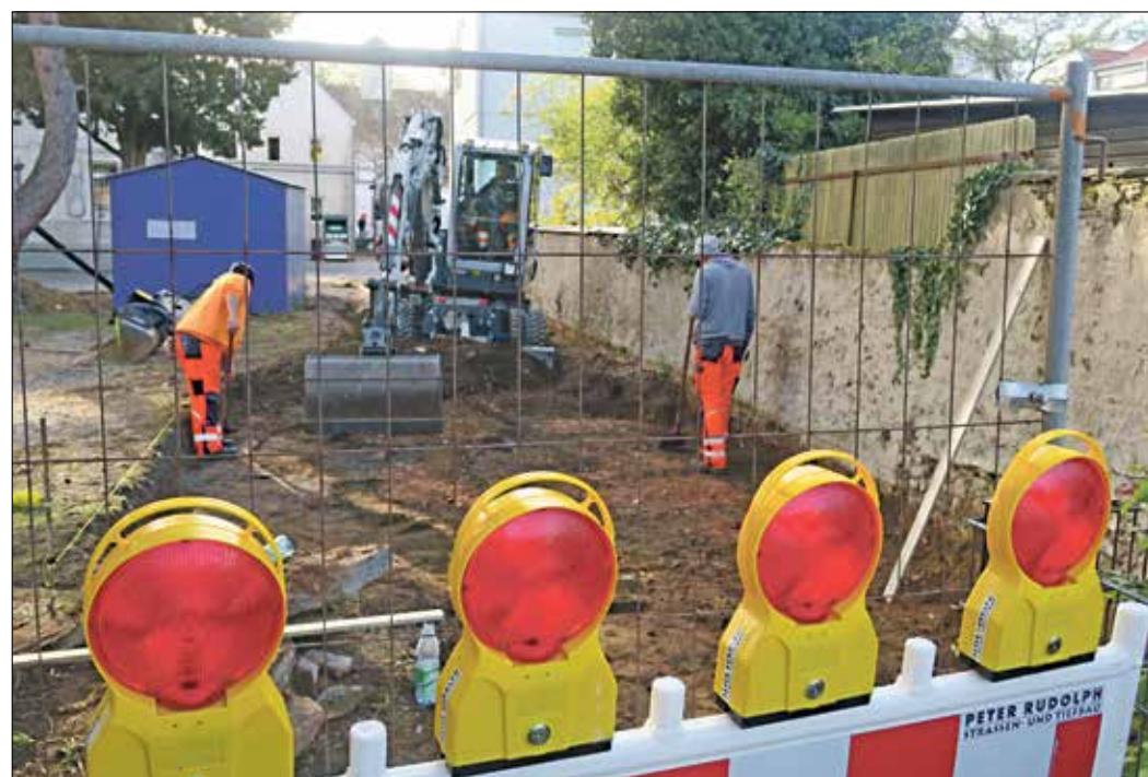
DIE BAUARBEITEN am Anna-von-Frankenstein-Weg gehen zunächst erst einmal weiter. (Bild: Ralf Hellriegel)
