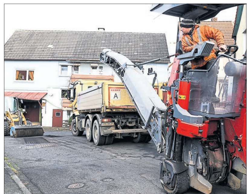
In Breitenbach wird unter anderem die Straße vor der Kirche saniert.
