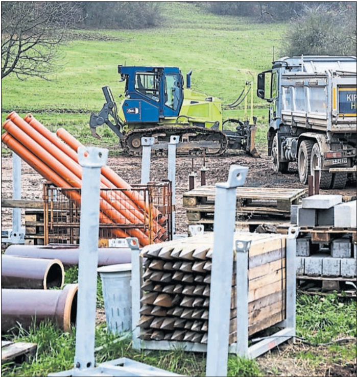
Die letzten Vorbereitungen werden im Baugebiet Am Brunkenberg in Schlüchtern getroffen: Bald wird hier asphaltiert.
