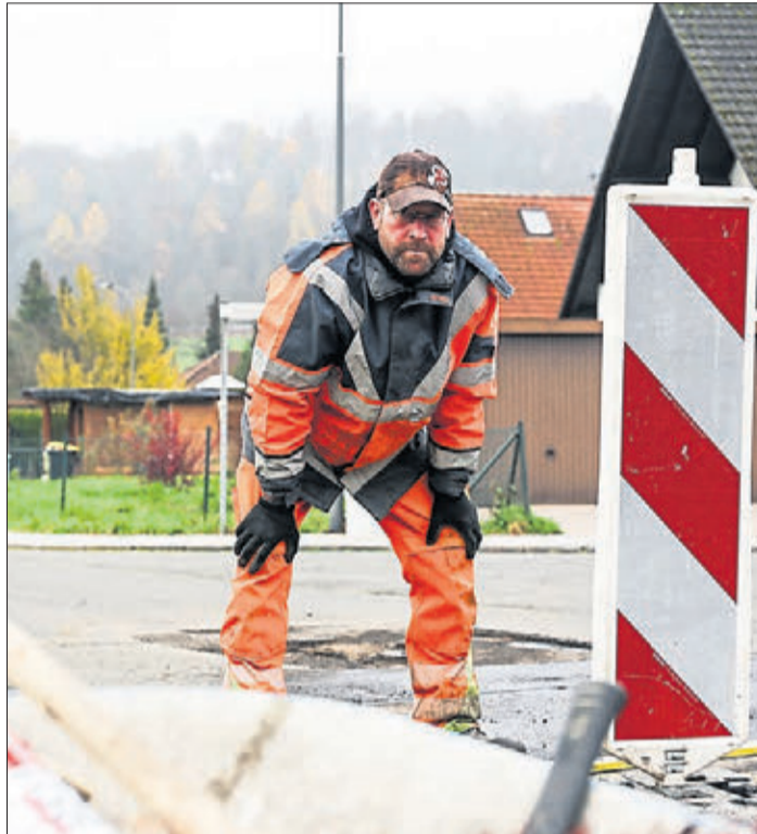
Einzelne Teilstücke werden in Kressenbach erneuert.
