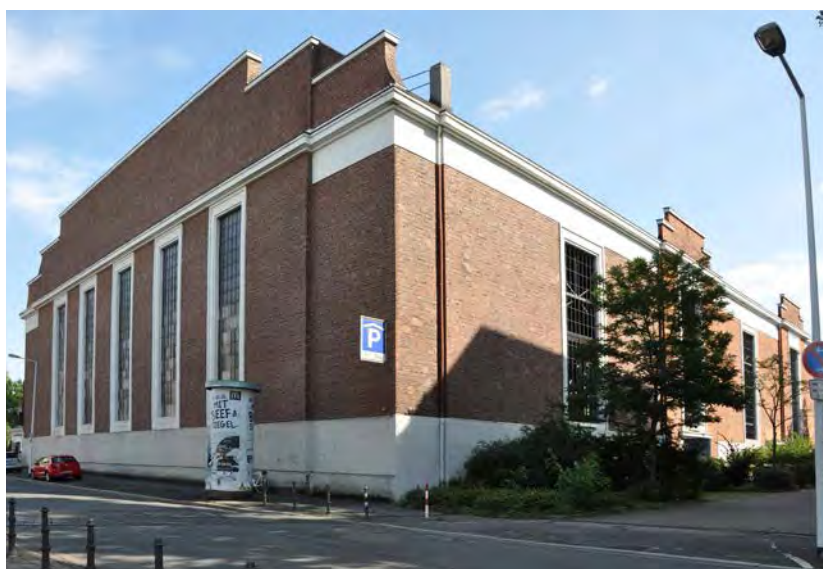
Ehemalige Zeppelinhalle, Landwehrstraße
