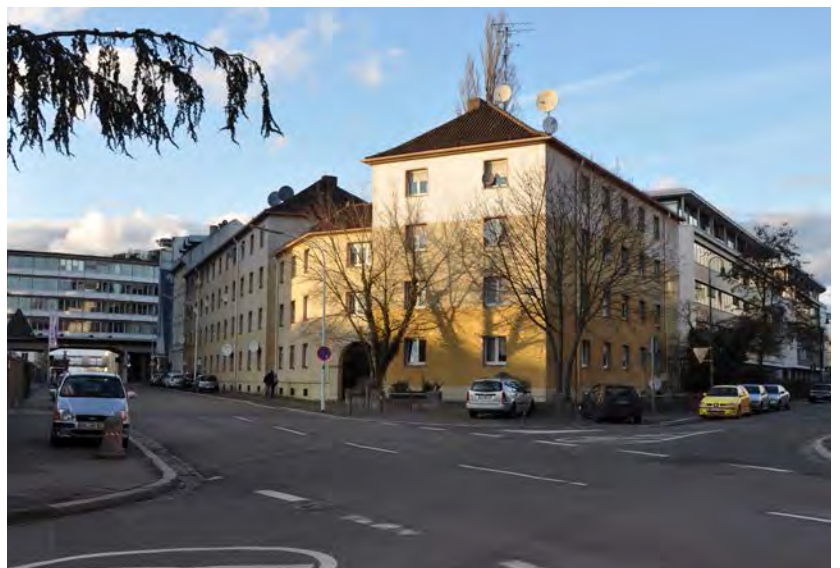
Geschosswohnungsbau, Dolivostraße / Ecke Feldbergstraße
