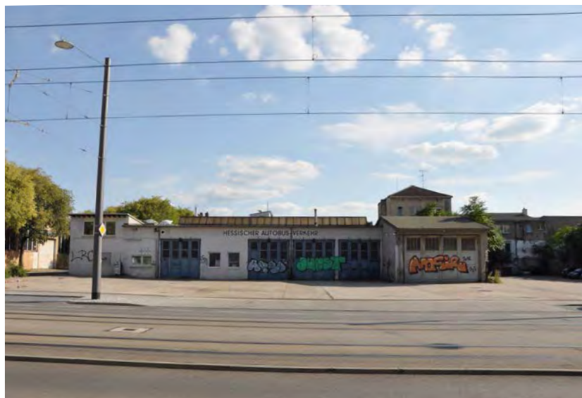
Brachgefallene Gebäude, Bismarckstraße
