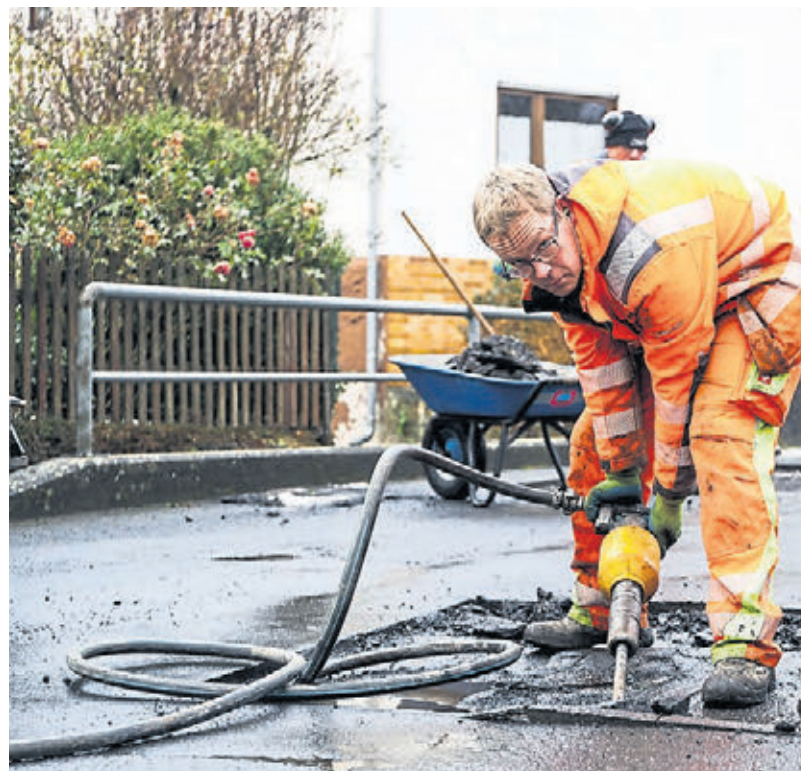
Den Stemmhammer im Griff, die Kamera im Blick – Multitasking im Straßenbau.
