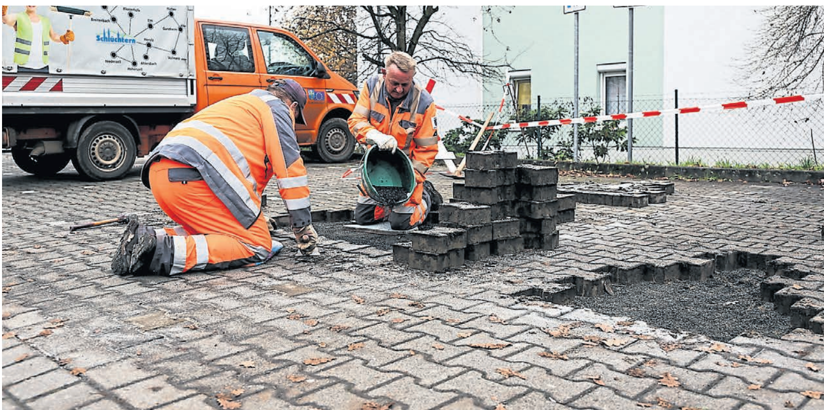
Bauhofmitarbeiter legen einen Behindertenparkplatz an.
