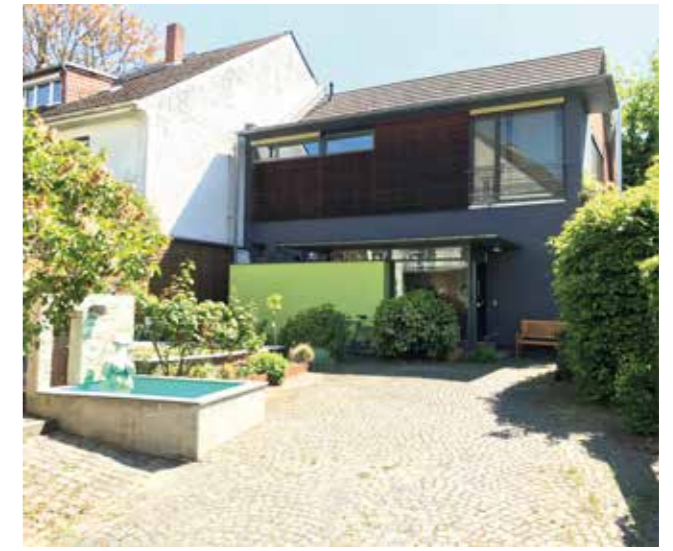
Haus und Hof in der Gardistenstraße nach der Sanierung
