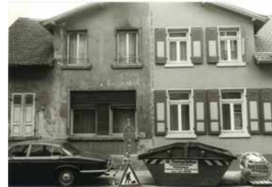
Liebfrauenstraße 47 vor der Sanierung
