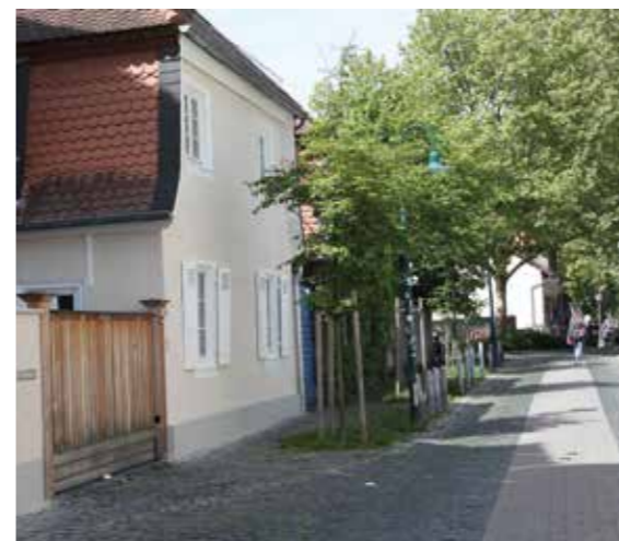
Saniertes Haus in der Gardistenstraße
