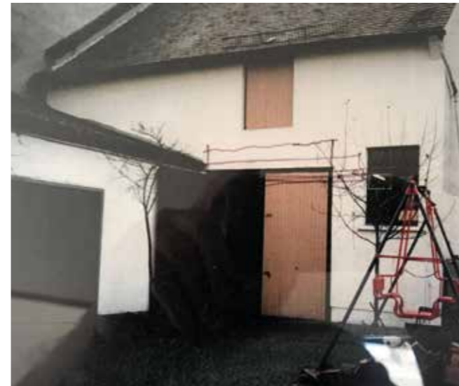
Haus und Hof in der Gardistenstraße vor der Sanierung
