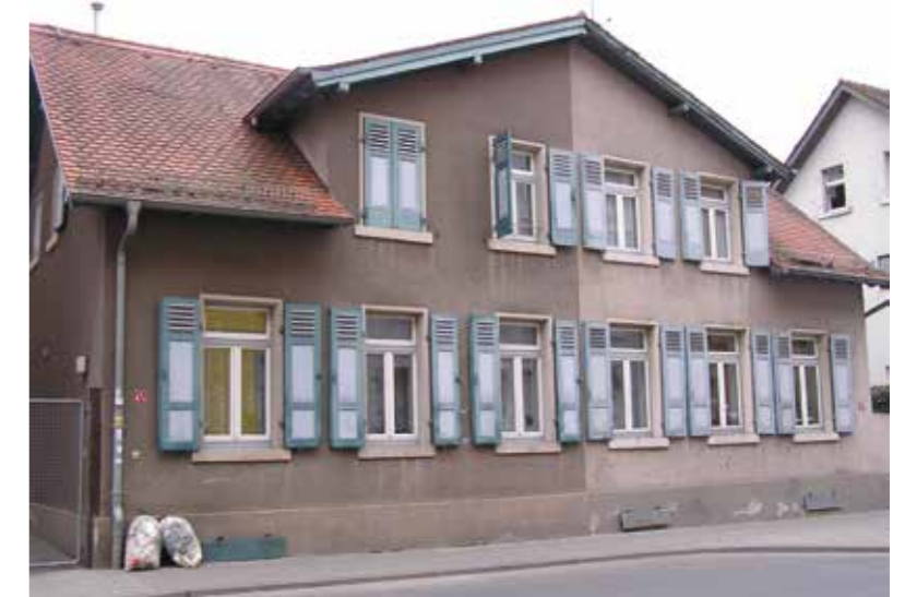
Liebfrauenstraße 47 nach der Sanierung
