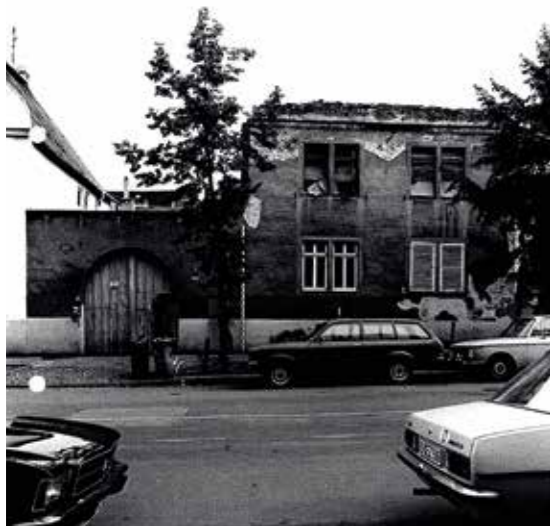
Haus in der Magdalenenstraße vor der Sanierung
