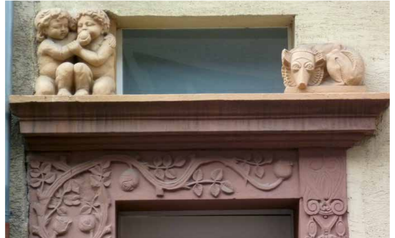
Oben und unten: Auch auf Details wurde bei der Sanierung wertgelegt
