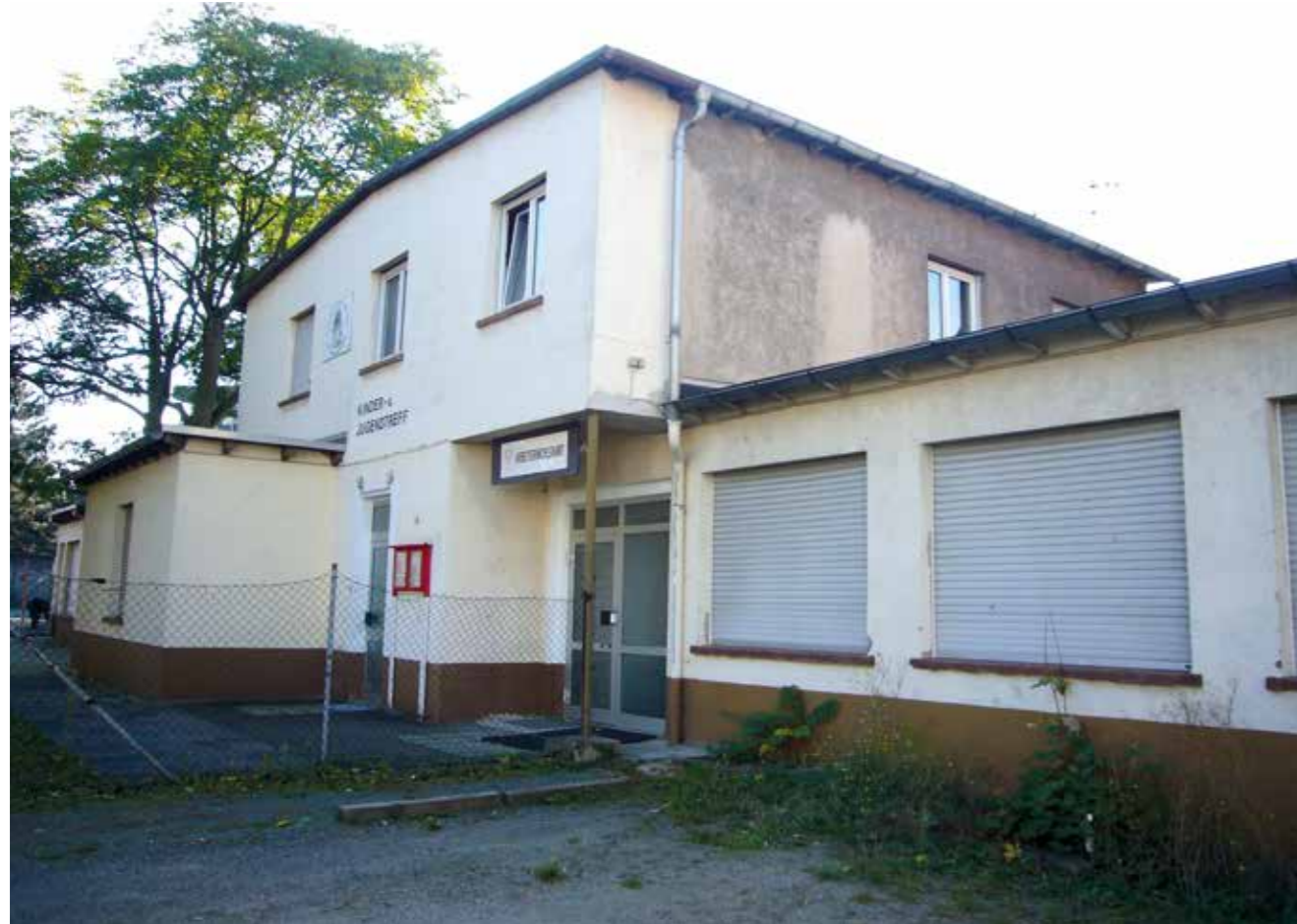
Grundstück des Kinder- und Jugendzentrums vor dem Bau
