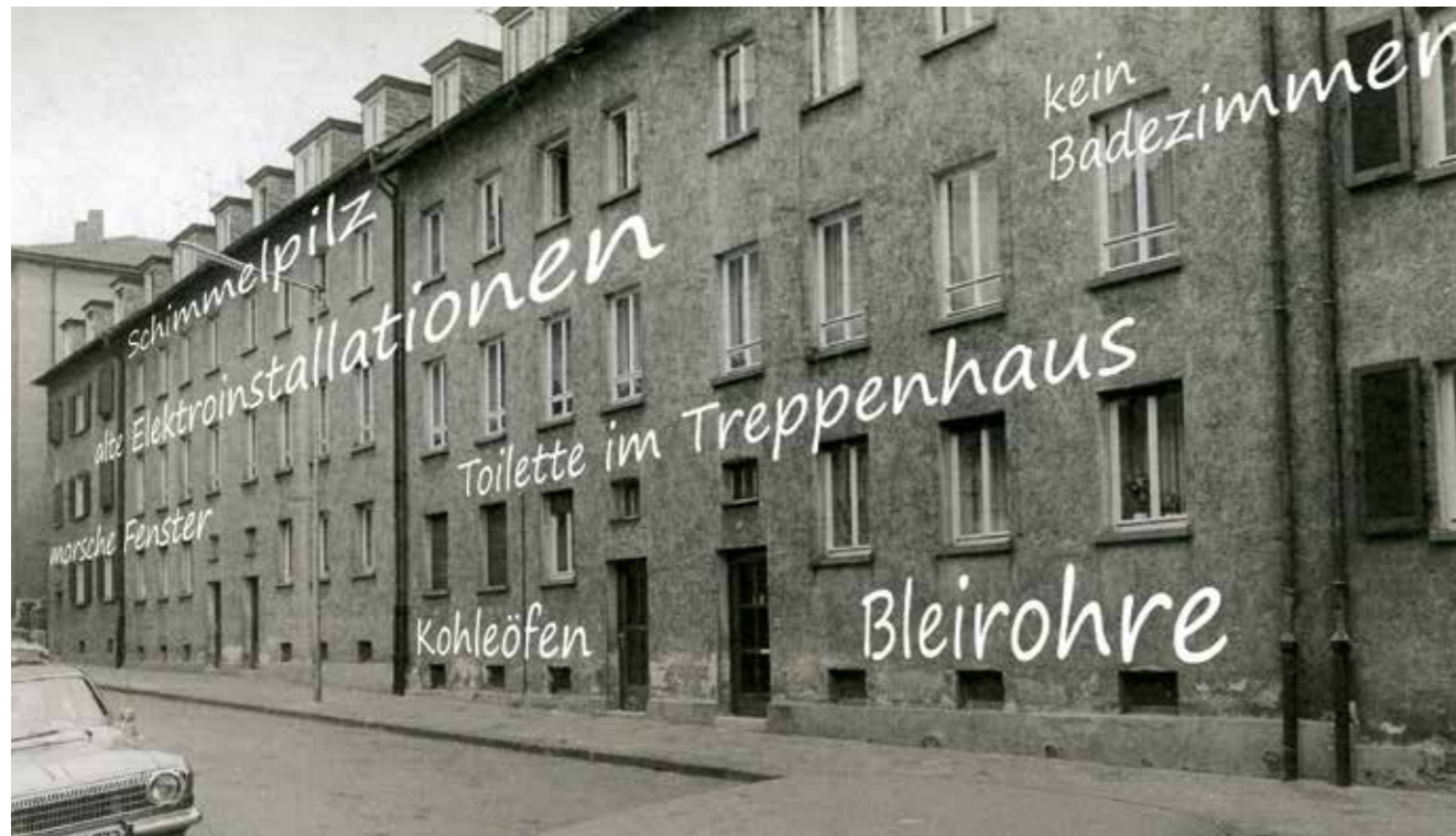
Haus in der Kaupstraße, Zustand vor Sanierung
