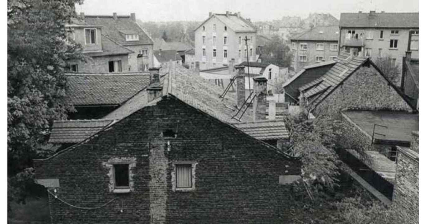
Baasblock vor der Sanierung
