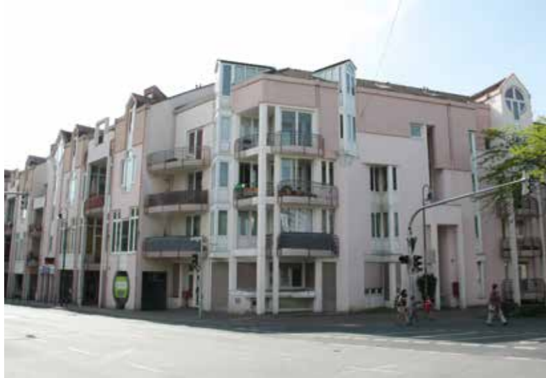
Dieburger Straße 6-8, Neubau
