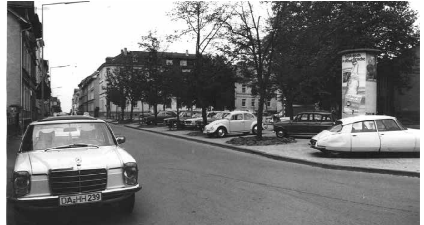
Schlossgartenplatz vor der Sanierung
