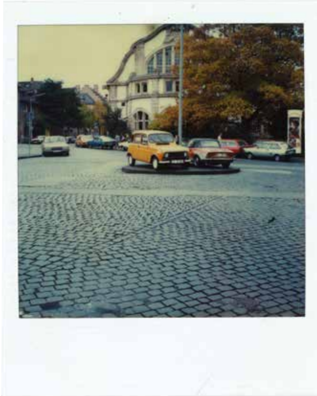
Kantplatz vor der Sanierung – Autos wurden einfach abgestellt
