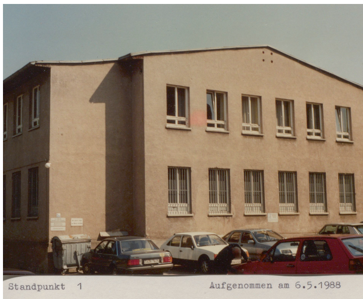
Abb. oben: Dienstgebäude Ahastraße 5a, 1988
