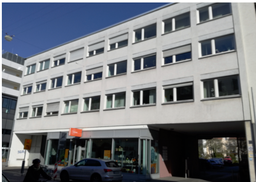
Abb. links: Gebäude/Hofeinfahrt, Rechnungsprüfungsamt, Außenansicht Elisabethenstraße.
