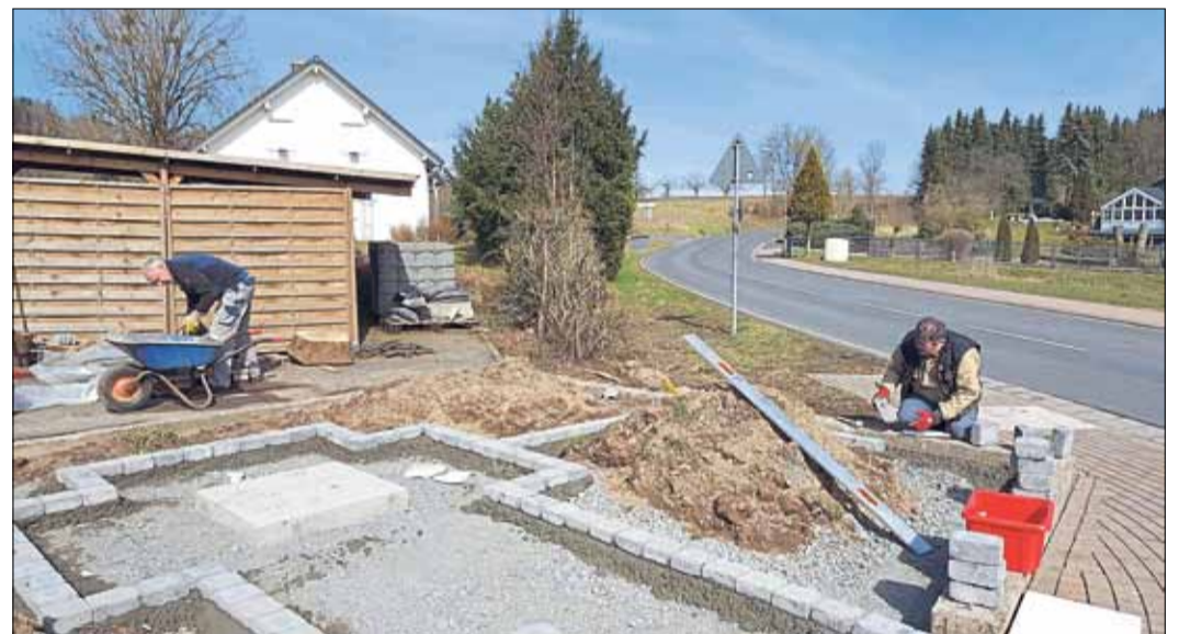
In Eigenleistung gestalteten Helfer der Jagdgenossenschaft Weiperz und des Verwaltungsrates der Kirchengemeinde St. Wigbert Weiperz den Standort des Bildstockes. Hier sind Wigbert Müller (links) und Stefan Wald beim Pflastern im Einsatz. Fotos: Walter Dörr
