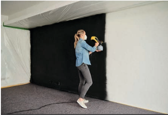
Eva Brenner zeigt es: Mit einem Farbsprüngerät geht der Farbauftrag schnell und gleichmäßig voran. Foto: djd-k/J. Wagner GmbH
