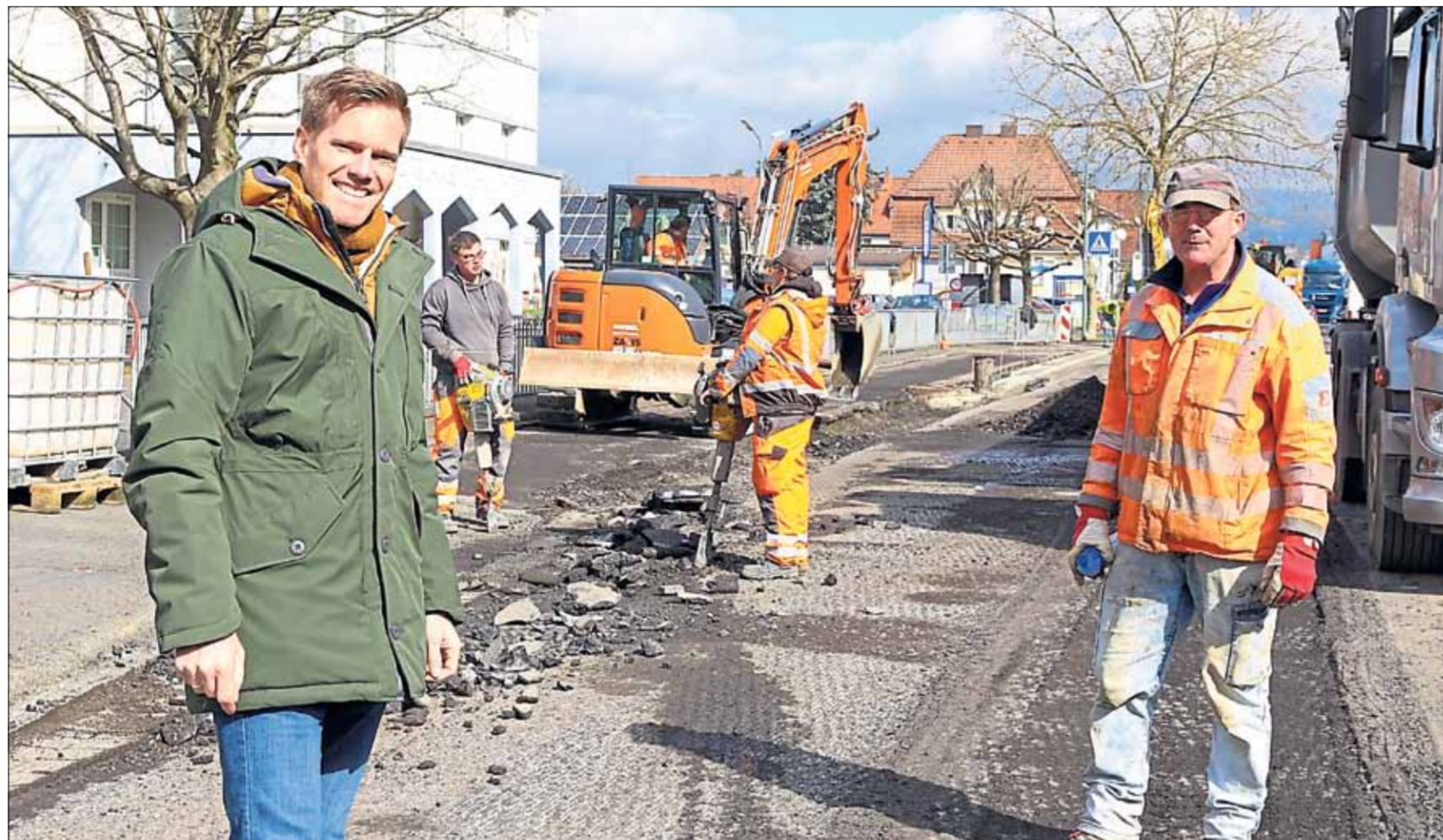
Jan Knüttel (links) vom städtischen Bauamt bespricht mit Polier Klaus Maienschein die Sanierung der Lotichiusstraße. Mittlerweile sind die Arbeiten dort beendet.
