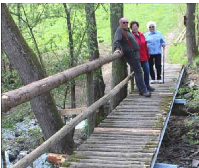
Die Brücke über die Ulmbach südlich von Marborn kann nach erfolgter Instandsetzung wieder genutzt werden. Zu erkennen ist Initiator Hans-Jürgen Salomon mit zwei Frauen, die die Brücke gerne nutzen. Foto: F. Christ
