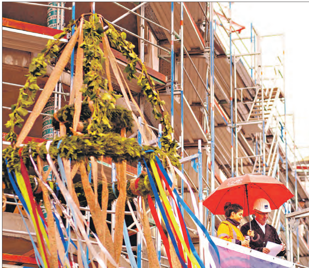
DER RICHTKRANZ IST HOCHGEZOGEN und der Richtspruch von Bauleiter Mathias Hupe ist – gut beschirmt von Frau Hilal Kurt, beide von der HTI Bau – verkündet. (Zum Bericht) (Foto: HDV Darmstadt)
