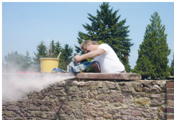
(1) Restaurierung der Friedhofsmauer
