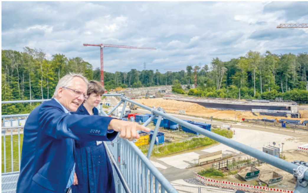
Die Darmstädter Landtagsabgeordnete Hildegard Förster-Heldmann (GRÜNE) mit Jörg Blaurock dem Technischen Geschäftsführer von GSI und FAIR auf der Aussichtsplattform in Wixhausen mit Ausblick auf das 20 Hektar große Baufeld auf dem seit 2017 der Ringbeschleuniger gebaut wird. Mit dem Bau der Beschleunigerzentren FAIR ist derzeit eines der weltweit größten Forschungsvorhaben in der Entstehung. (Foto: Oliver Stienen)
