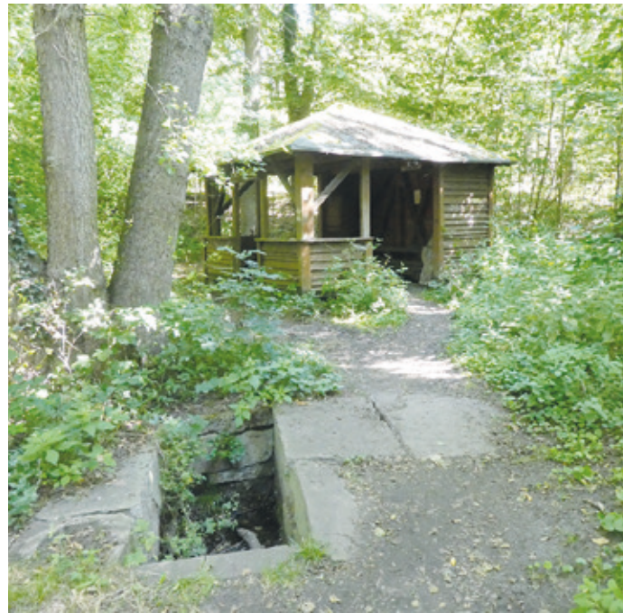
(Abb. 8) Das Ludwigsbrunnchen mit der Schutzhütte
