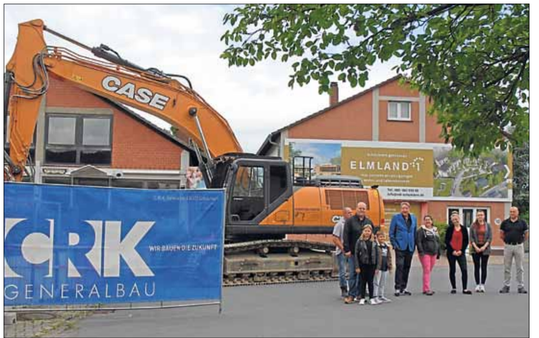
Jetzt geht's los: Auf dem Knothe-Areal wurde mit den Abbruch- und Erdarbeiten begonnen. Darüber freuen sich besonders Carsten R. Kulbe und Diana Razavi (Mitte). Foto: Ulrich Schwind
