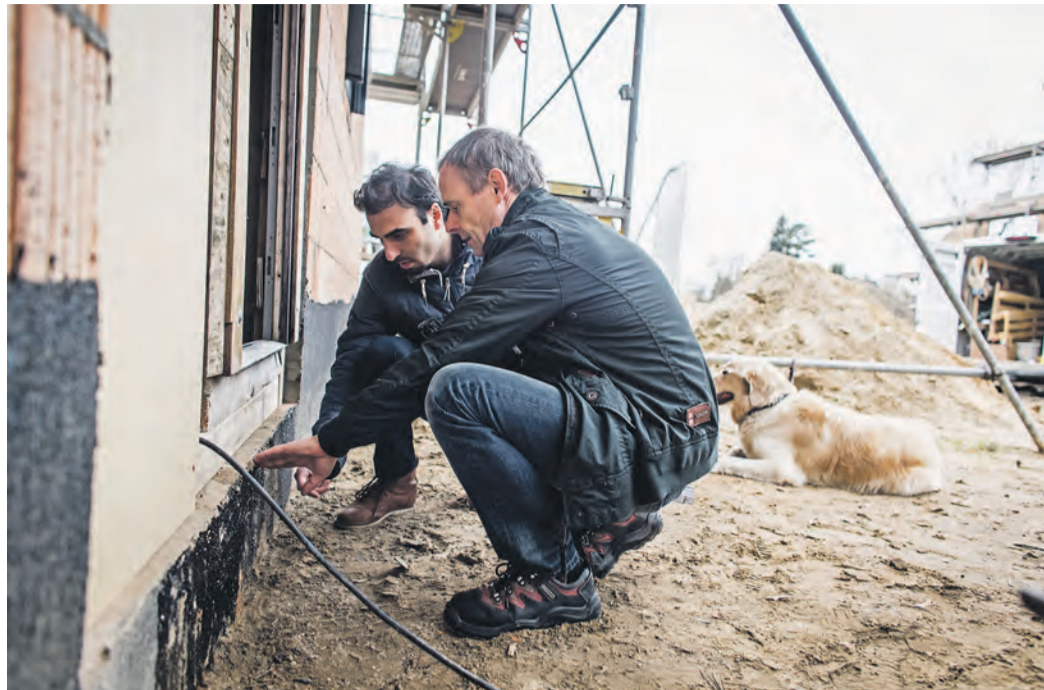
WER BEREITS BEIM BAUEN an Barrierefreiheit beispielsweise bei den Hauszugängen denkt, hat es später einfacher, das Haus an altersgerechte Bedürfnisse anzupassen.
