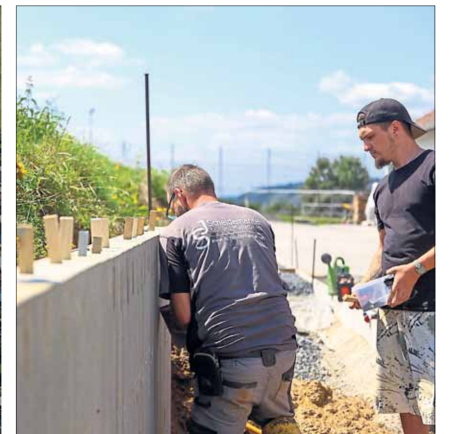
Mittlerweile ist der Außenbereich des Kindergartens in Gundhelm fertig.
