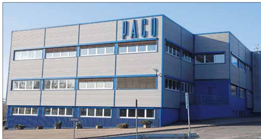
Die PACO-Gruppe beschäftigt 335 Mitarbeiterinnen und Mitarbeiter, 200 von ihnen am Standort in Steinau. Hier das Gebäude im Industriegebiet West. Foto: PACO
