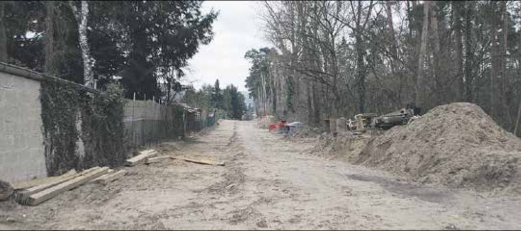
SO SAH ES entlang der Kanaltrasse während der Baumaßnahme zum Tannenbergsammler aus. Die Schneise soll nun wieder einer naturnahen Waldrandgestaltung Platz machen. (Foto: Mi / Gemeinde Seeheim-Jugenheim)
