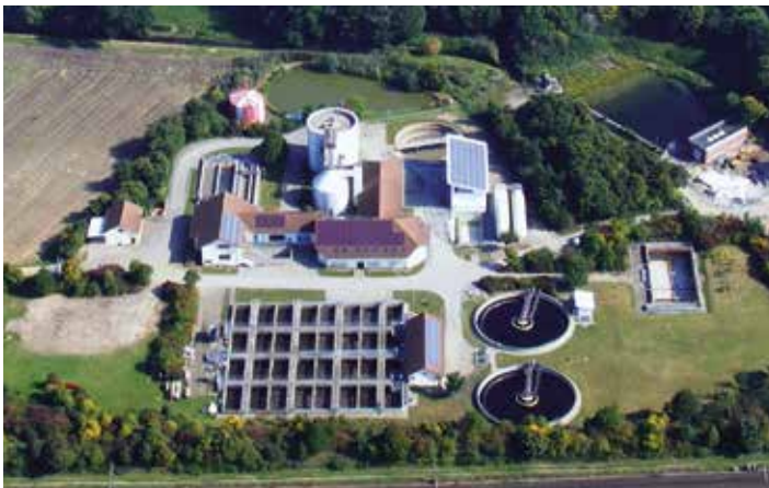
Die Zentralkläranlage in Goddelau
