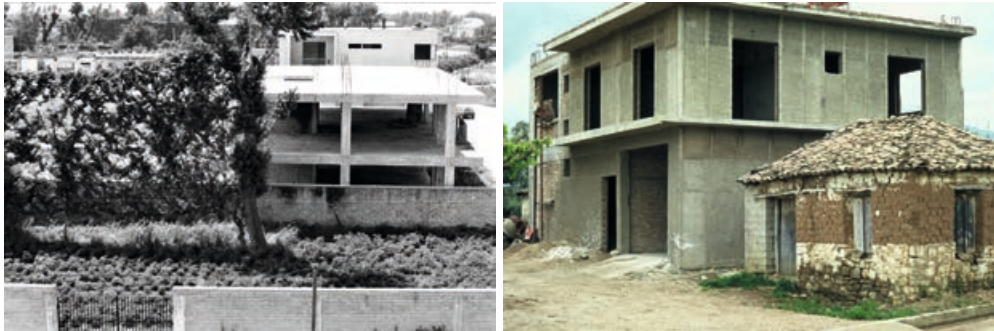
Abb. 2.20: Links: Rohbauten auf eigenem Grundstück durch Verdienste, z. B. als Gastarbeiter. Vielleicht hat man in Esslingen die schwäbische „Häuslebauer-Mentalität“ schätzen gelernt. Rechts: südlicher Rand der Sarnoebene bei S. Antonio-Abate, ein fast fertiger Neubau neben altem alten Wohnhaus. Fotos: 1989.
