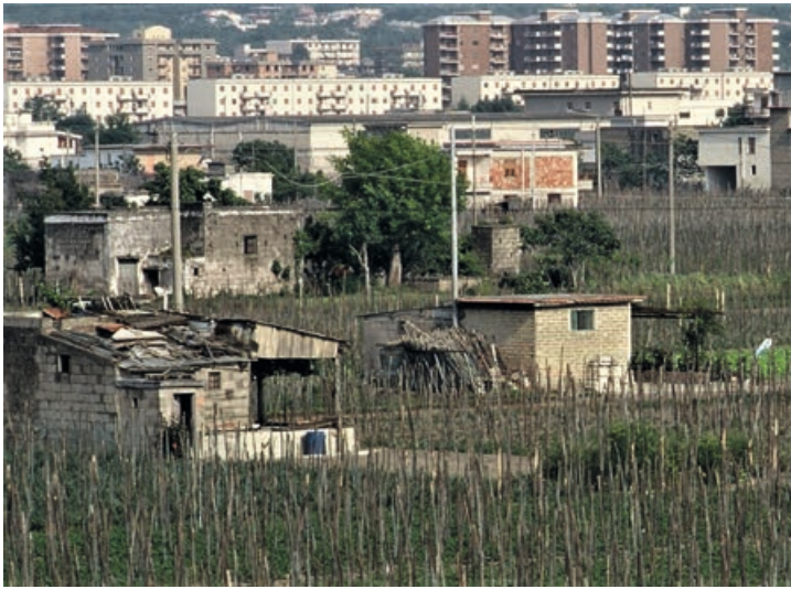
Abb. 2.22: Im Umland von Nocera: Nicht nur individuelle, oft lange wahrende Etappen-Bauten von Gastarbeitern kennzeichnen die Peripherie der alteren Stadte im Sarnogebiet. Auch groere Wohnbauprojekte sind Folgen der Zuwanderung, des sozialen Wandels. Vordergrund: Relikte alter Agrarstruktur, dahinter groe Wohnblocke. Die Einwohnerzahl des Wirtschaftsgebietes Nocera-Sarno stieg bis ca. 2000 unvermindert an, sank danach leicht ab.
