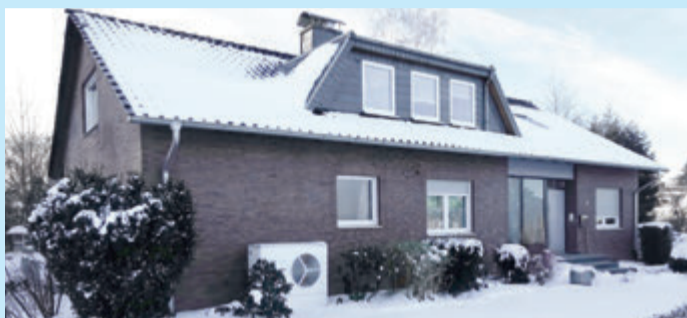
Bezahlbare Behaglichkeit: Wärmepumpen sind auch für Bestandsbauten eine Alternative zum Heizen mit Öl oder Gas.
