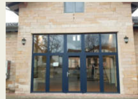
Der Blick von außen auf die neuen Räume.
