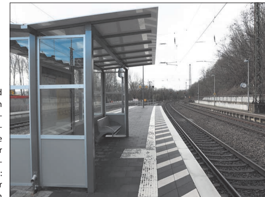
Der Bahnhof wird saniert und barrierefrei gestaltet.
