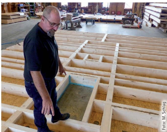
Eine komplette Obergeschossdecke liegt auf dem Hallenboden. Dirk Hartmann, Geschäftsführer von Hartmann Holzbau in Lauterbach, steht quasi auf dem künftigen Dachboden eines Wohnhauses.
