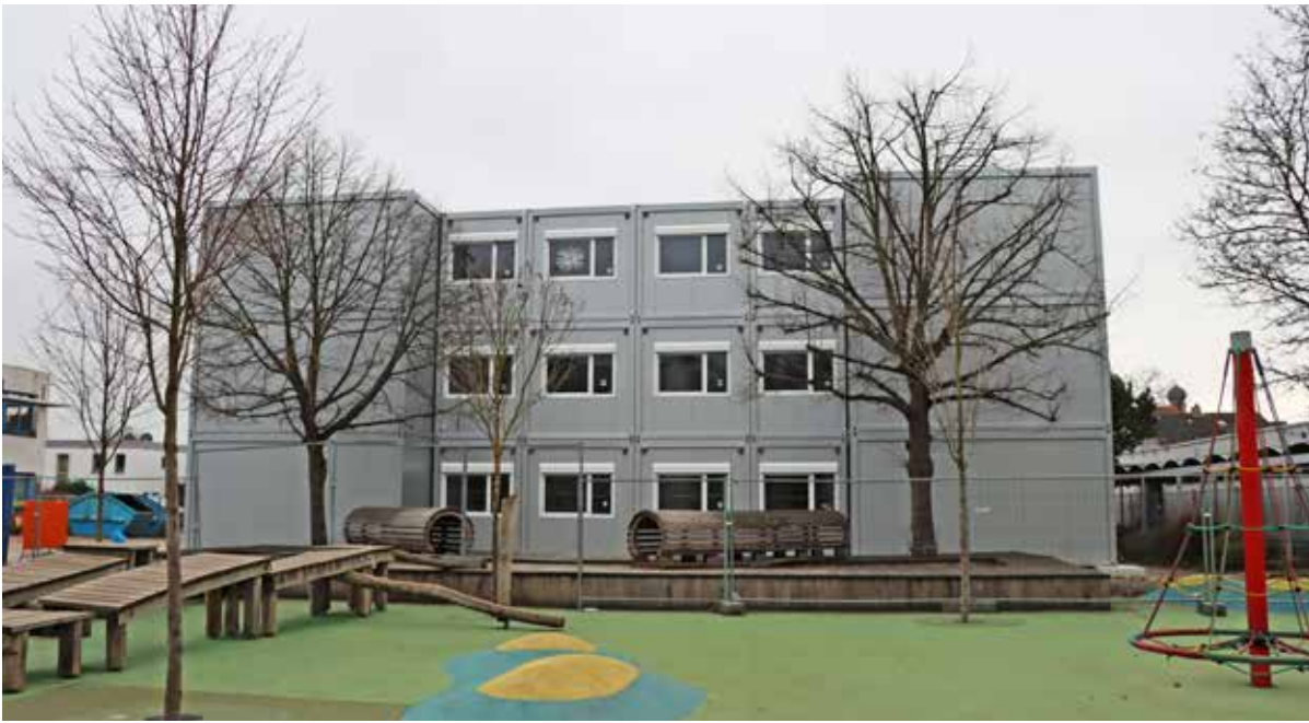
Die Containeranlage an der Gustav-Brunner-Schule steht bereits. Der Innenausbau läuft. In den Osterferien ziehen Klassen, Lehrkräfte und Verwaltung dorthin um, damit danach das alte Verwaltungsgebäude abgerissen und neu gebaut werden kann.
