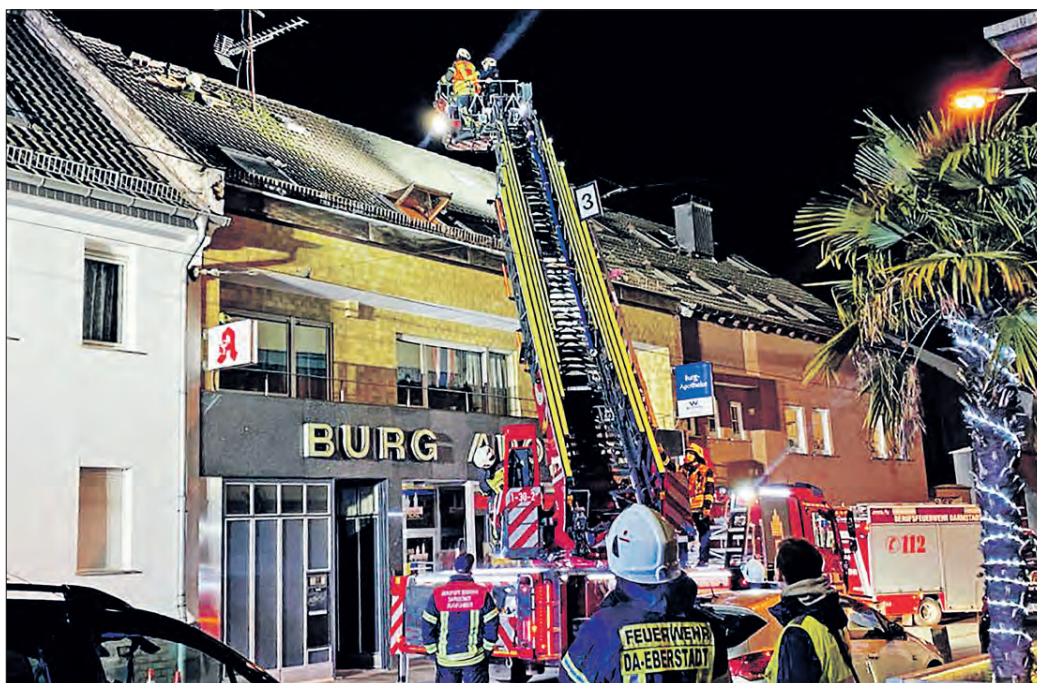
MIT DER DREHLEITER musste die Feuerwehr in Eberstadt auf ein teilweise abgedecktes Dach eine Notbedachung installieren. (Zum Bericht) (Foto: Jens Rose)
