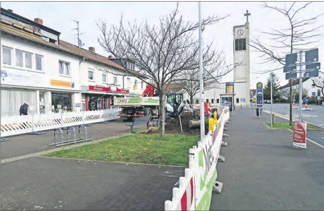
BAUSTELLE STRAUBPLATZ. Bis Mitte des Jahres wird der zentrale Platz in der Heimstättensiedlung grundlegend verschönert sein. (Zu den Berichten) (Foto: Ralf Hellriegel)
