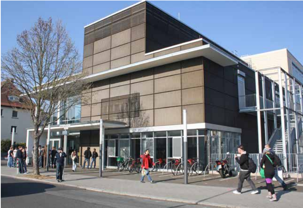
Das bauliche Großprojekt in Friedberg: Die Hochschule wächst räumlich von der Wilhelm-Leuschner-Straße hinab in die Nähe des Bahnhofs.
