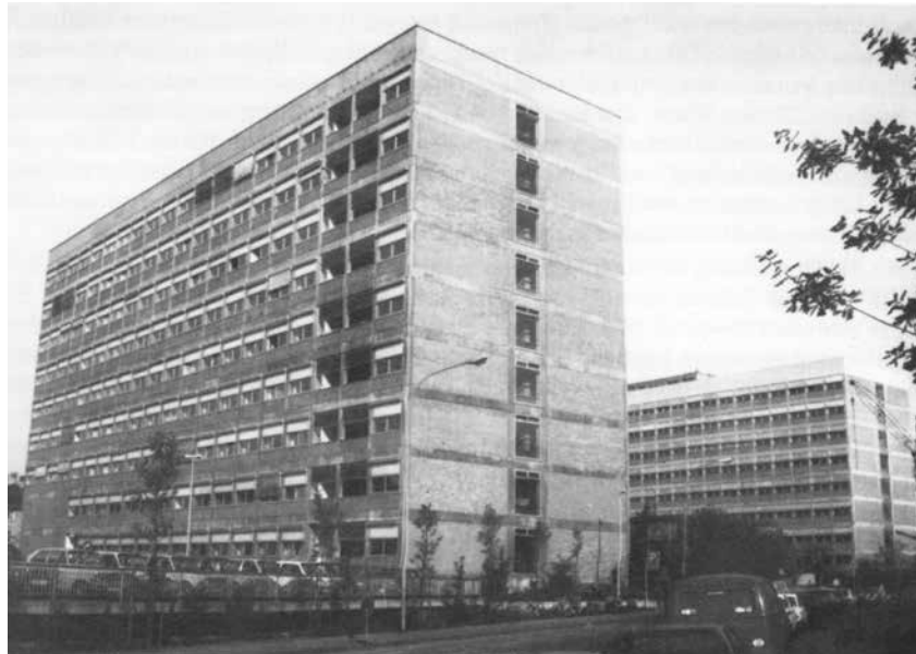
Ein Zwillingsgebäude bringt 1978 großen Flächenzuwachs in Gießen.
