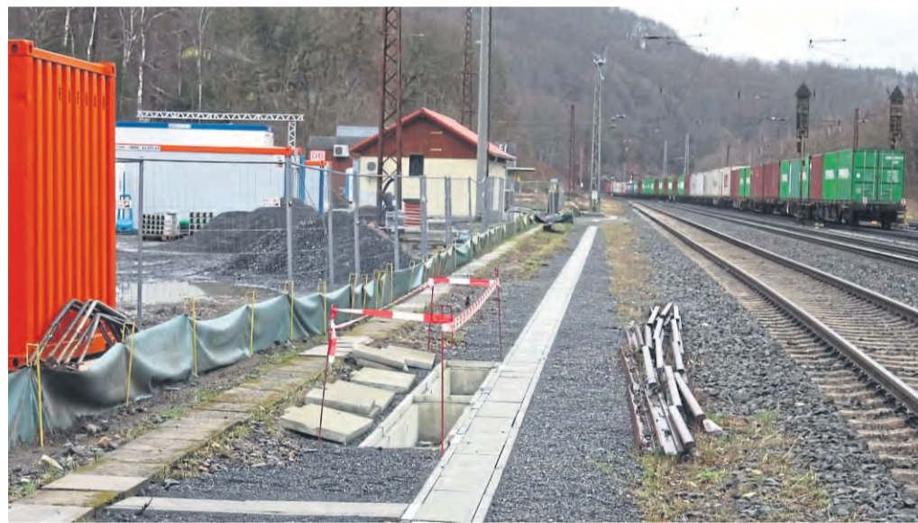
Viel gebaut wird auch im Bahnhof Elm. In der Bildmitte ist das neue Stellwerksgebäude zu erkennen.
