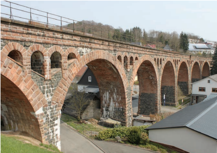
Bild 8: Mit seiner markanten Bogenkonstruktion prägt das um 1900 errichtete, 13 Meter hohe und leicht geschwungene Eisenbahnviadukt der Salzbödebahn das Ortsbild von Hartenrod (Kreis Marburg-Biedenkopf).
