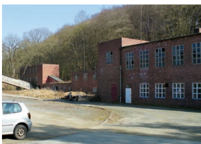
Bild 2: Die alten Gebäude der Grube Ottilie bei Braunfels (Lahn-Dill-Kreis) wurden nach dem Zweiten Weltkrieg von der Firma Krupp in Essen durch neue Gebäude im Stile der Neuen Sachlichkeit ersetzt.
