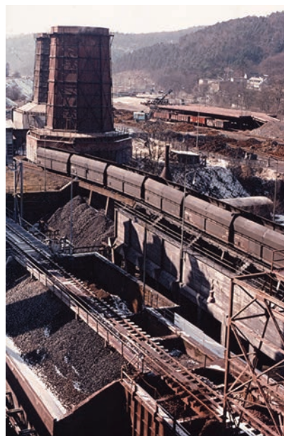
Bild 4: Das Bild zeigt einen kleinen Teil des Hochofenwerks Oberscheld (Lahn-Dill-Kreis) mit Kühltürmen und Kohlebunkern. Die Anlagen sind heute fast völlig verschwunden und überbaut.
