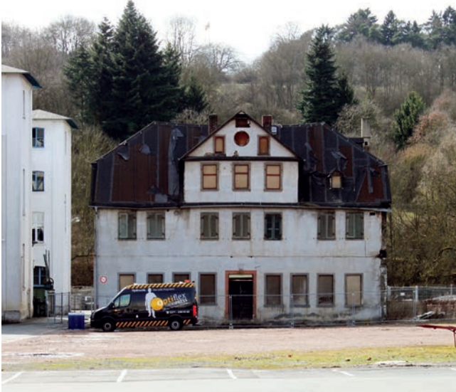
Bild 12: Das stattliche Haus des Hüttenherrn Daniel Treupel von 1827 stand mitten auf dem Gelände der Neuhoﬀnungshütte in Sinn (Lahn-Dill-Kreis). Es musste 2015 einem Supermarkt weichen.
