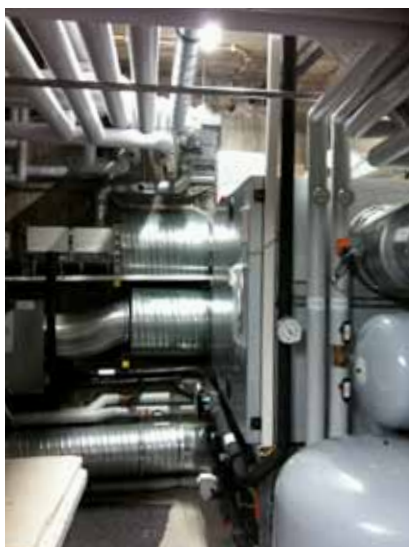
Unsere Abbildungen zeigen unten den Gewölbekeller vor dem Umbau und oben einen Blick in den Technik-Raum, Abb.: Lupold v. Lehsten. Die weiteren Bilder zeigen den Konferenz- und Seminarraum nach der Fertigstellung, Abb.: Jan Bitter, Berlin.
