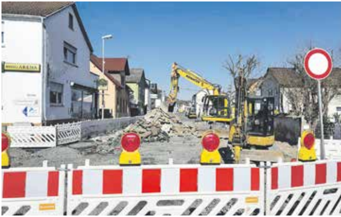
Hinweis: Die Zufahrt zu den Gewerbebetrieben bzw. Geschäften und Lokalen in der Rheinstraße ist bis zur Baustelle in beide Richtungen selbstverständlich weiterhin möglich ist. Auch die im Bau Feld liegenden Betriebe sind geöffnet und zu Fuß jederzeit erreichbar!
